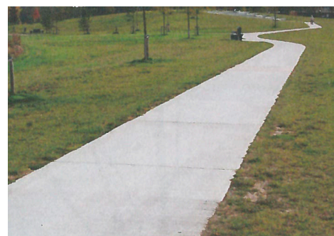
bedrijfsvloerplaten (loopstroken) indien mogelijk, kunnen hiervoor in de slopen kassen aanwezige vloerolaten her- gebruikt worden
